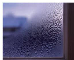
En vieillissant, les entretoises en aluminium ont un coefficient de conductivité thermique élevé et sont souvent à l'origine de la formation d'eau de condensation à proximité du cadre. On utilise de nos jours pour les intercalaires ou entretoises des matériaux mieux adaptés donnant un vitrage à «bord chaud» (warm edge), améliorant le coefficient d'isolation U de la fenêtre d'environ 10 %.
